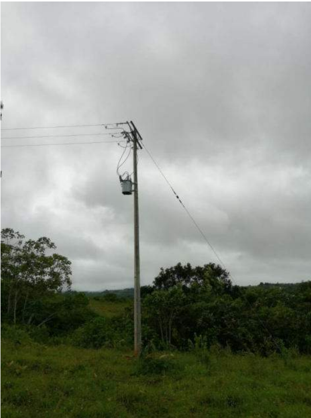
Ilustración 8 poste energía recién instalado sirve de guía hacia el lote.
